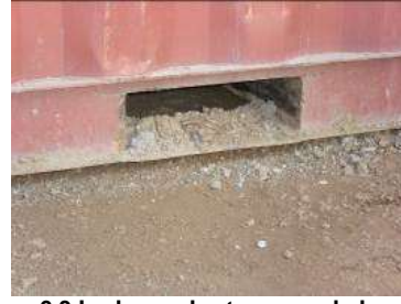
Figura 6.3 Lodo en abertura para la horquilla
