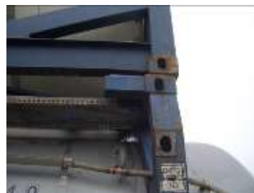
Figura 4.9 Espacio vacío en la abertura para izada lateral secundaria
