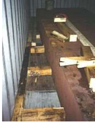
Figura 7.45 Bloqueo transversal de chapa gruesa de acero
